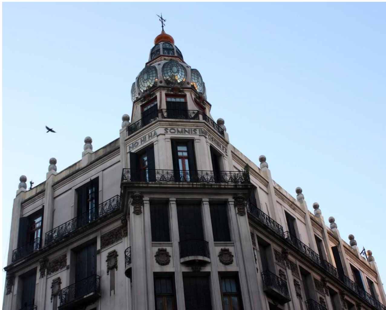
Arquitecturas. Cúpulas y sueños. Edificio: No hi ha somnis impossibles (No hay sueños imposibles, en catalán) (1907). Avenida Rivadavia esquina Ayacucho, Balvanera, Buenos Aires, Buenos Aires.
